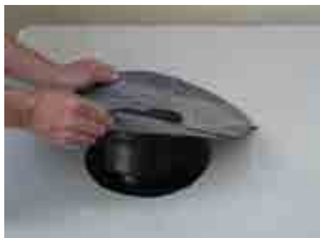
1. Прodelать отверстие Ø 255мм, закрепить воронку HL62H
