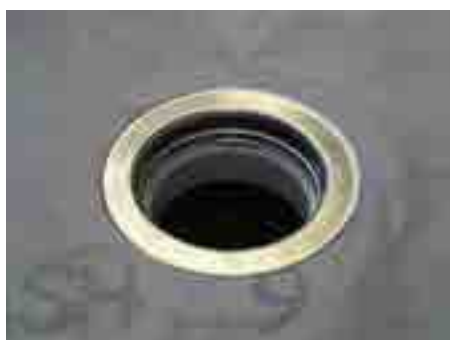
10. Зажать фильтрующий слой фиксирующим фланцем элемента HL350.0
