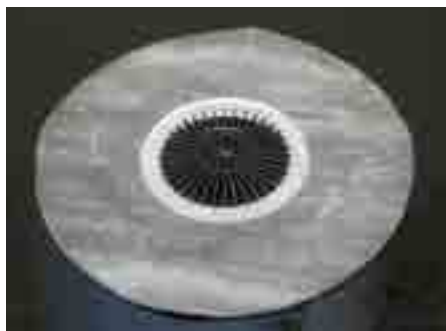
2. Нанести праймер, наклеить 1-й слой гидроизоляции
