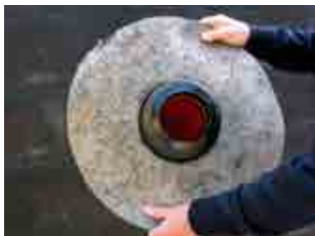
2. Надеть гидроизоляционную мембрану
