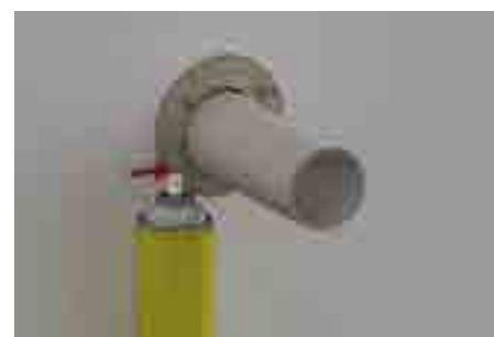
12. Заполнить пространство между отводящей трубой и парапетом монтажной пеной
