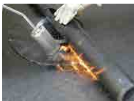
4. Наклеить 2-й слой гидроизоляции (до обжимного фланца)
