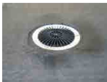
5. Так должна выглядеть воронка после укладки гидроизоляции
