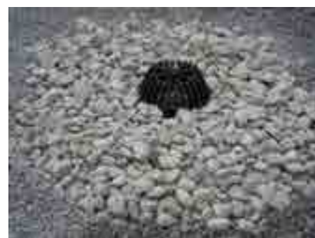
12. Засыпать гравием остальную поверхность кровли
